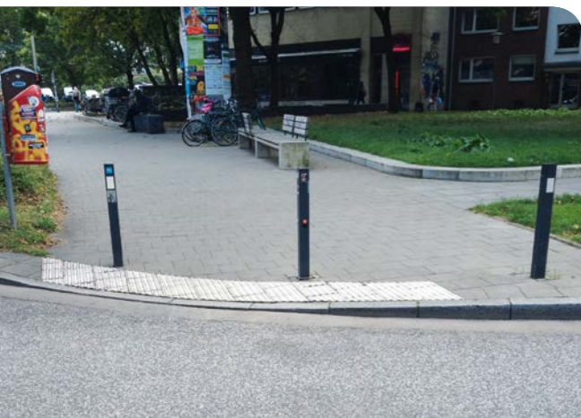
Eine vorbildliche Bordsteinabsenkung wurde am Schulterblatt an der Eimmündung der Eimsbütteler Straße realisiert
